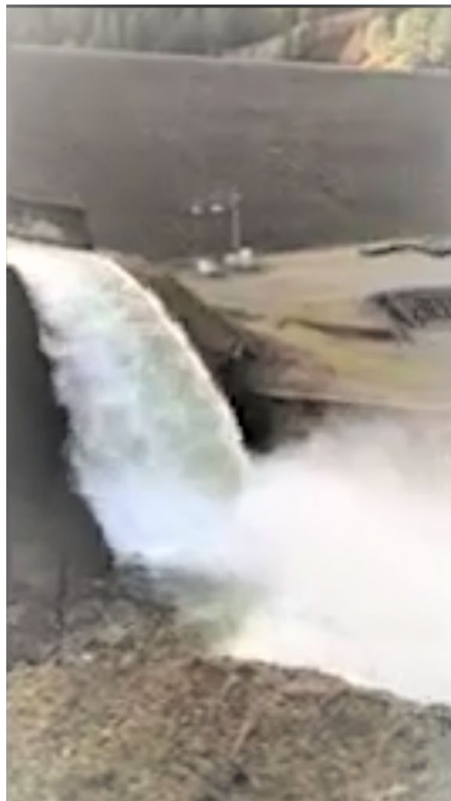
Ruth Lake Spillway
